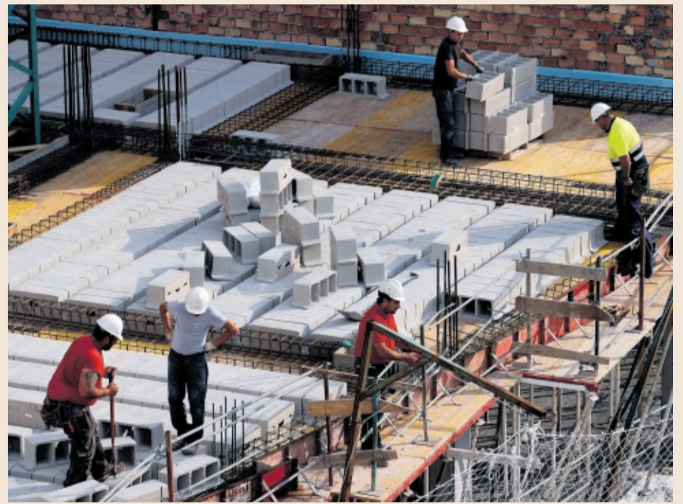
Trabajadores de la construcción levantan un edificio en Bilbao. EFE
